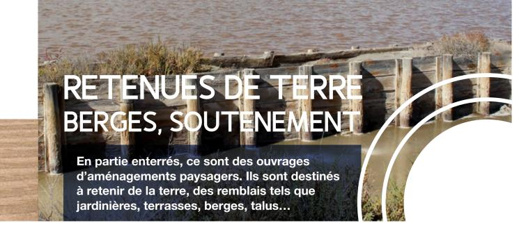
Le bois permet une adaptation aisée aux diverses topographies (pose simple et rapide même en cas de modifications). Les produits utilisés sont par exemple des bois ronds ou sciages.
